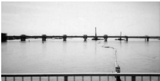
建設中の長良川河口堰
